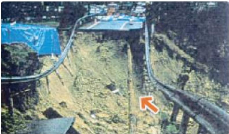
道路が崩落してもガス漏れしなかった中圧導管 (阪神・淡路大震災)
