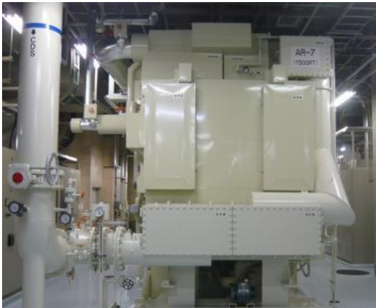
蒸気焚吸収冷凍機 (AR-7)
