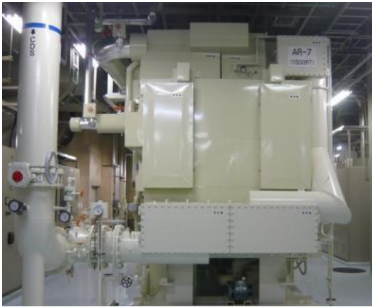
蒸気焚吸収冷凍機 (AR-7)
